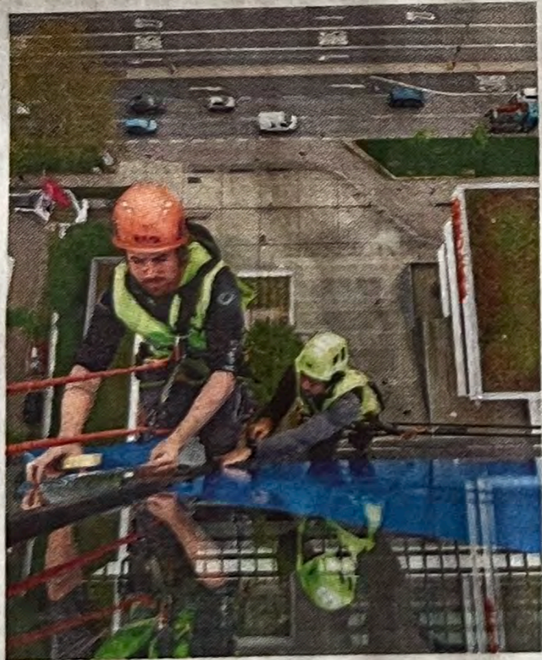
Kunstarbeit in schwindelnder Höhe an der Fassade des Geno-Hauses.
